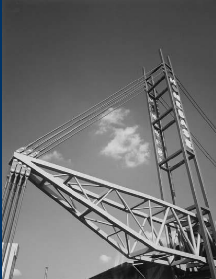
Homebase, London. Centralny maszt ze wspornikiem do napięcia lin-ciągów arch. Nicholas Grimshaw & Partners [6.2]
