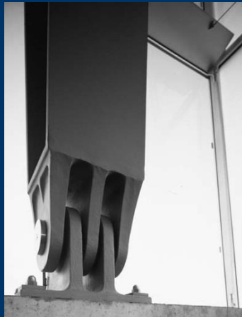
Podparcie przegubowe słupa stalowego [6.2.]
