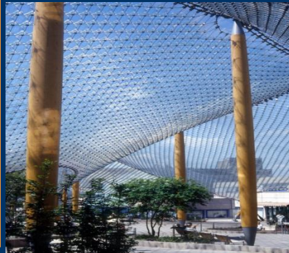
Homebase, London. Centralny maszt ze wspornikiem do napięcia lin-ciągów arch. Nicholas Grimshaw & Partners [6.2]
