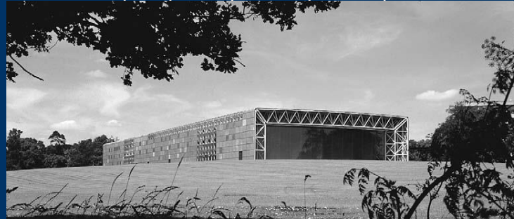
Rama kratowa jako nośny układ poprzeczny konstrukcji stalowej
