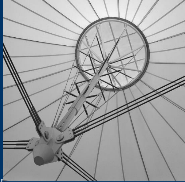
Maszt wewnętrzny napinający „namiot”. Channel Tunnel, UK, arch. BDP [6.2]
